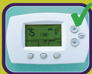
Termostato del aire acondicionado central
